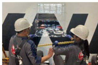
JA868Jヘリブレット加工を 施工する様子
