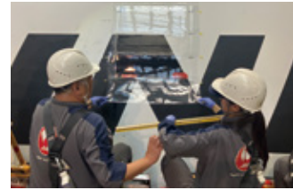
JA868Jヘリブレット加工を施工する様子
